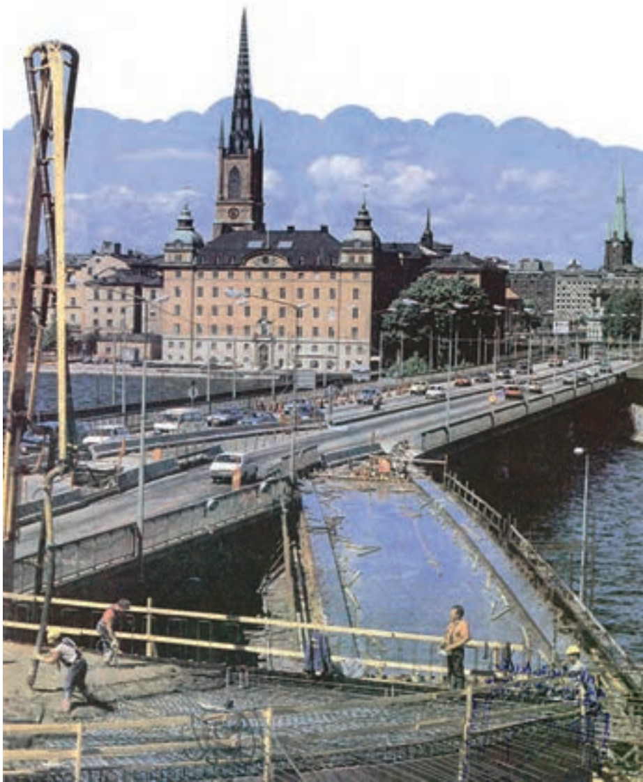
شکل ۶-۷- بتن آماده، در حال تخلیه به وسیله پمپ نصب شده بر روی کامیون
