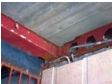
شکل ۵-۲۰- سافت تیرهای لانه زنبوری و نصب آنها
