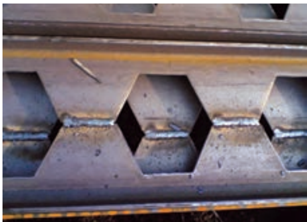
جوشکاری کامل دو طرف تیر لانه‌زن‌بوری
