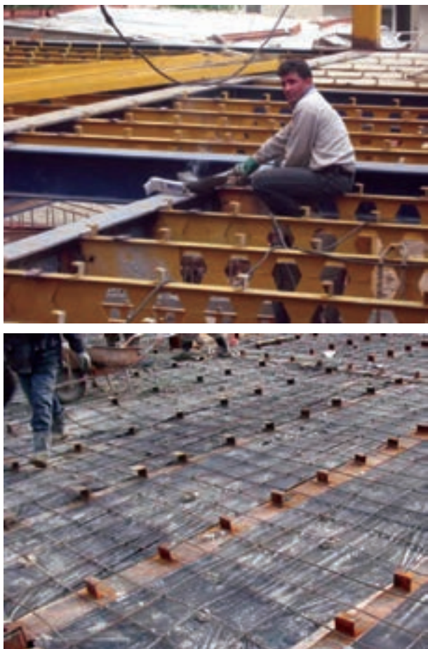
شکل ۵-۲۵- مراحل اجرای سقف کامپوزیت
