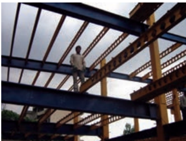
نصاب اسکلت در مال نصب تیرچه‌ها در سقف کامپوزیت
