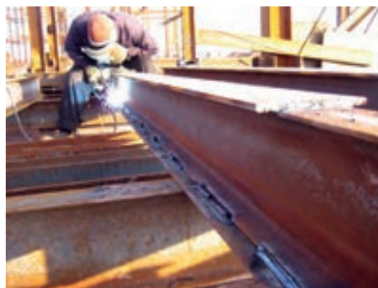
شکل ۵-۱۳- جوش‌کار در حال جوش‌کاری ورق تقویتی نیمرخ استاندارد تقویت شده
