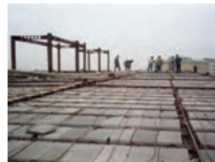
قرار دادن آرماتور حرارتی بر روی بلوک‌های سقف تیرچه بلوک برای جلوگیری از پدید آمدن ترک‌های عمیق در سطح بتن
