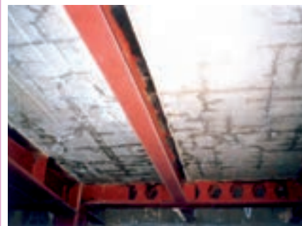
دال مرکب بتنی پس از بتن‌ریزی
