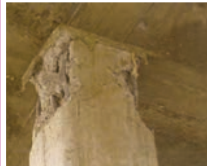
در بالای ستون به رگم نزدیکی به ناحیه‌ی اتصال با تیر، خاموتی مشاهده نمی‌شود و کمانش میل‌گردهای طولی، عاملی برای شروع خرابی در این موضع است، در حالی که طبق آیین‌نامه باید نزدیک محل اتصال تیر و ستون از خاموت‌گذاری فشرده (ویژه) استفاده می‌شد.
