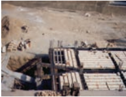
اجرای سقف تیرچه بلوک
