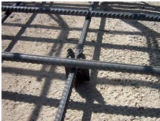
شکل ۱۱-۱۱- استفاده از فاصله انداز (Spacer) مهندسی
