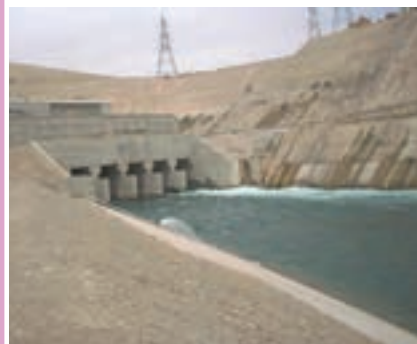
کانال بتنی آب
