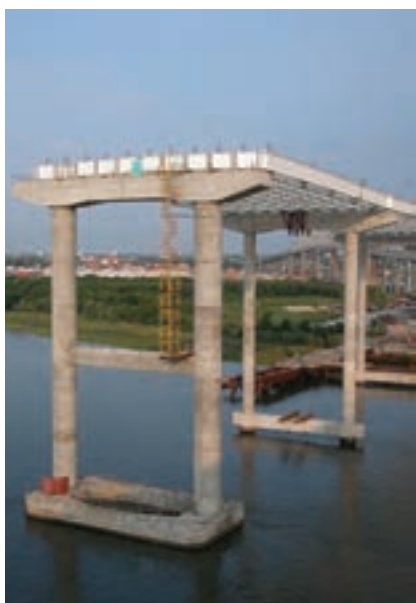
پایه‌های بتنی یک پل
