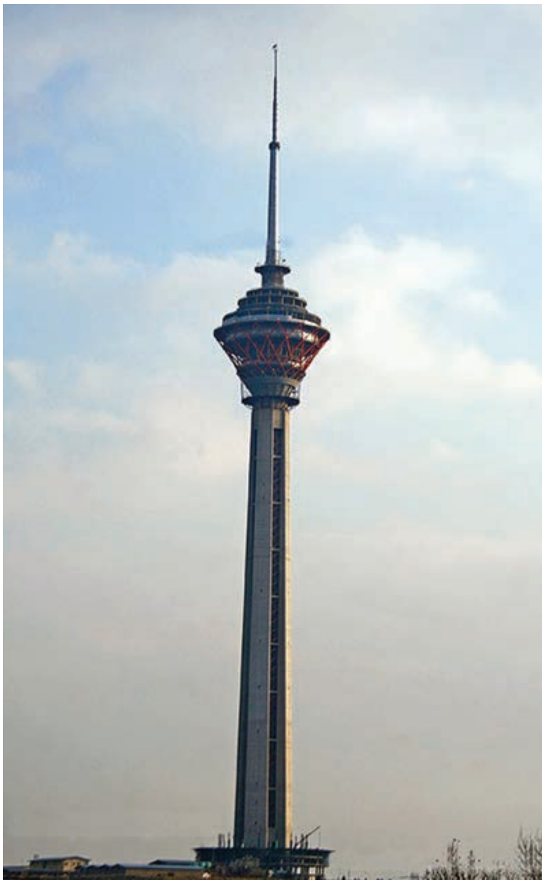
شکل ۱-۱- برج مخابراتی میلاد به ارتفاع ۴۳۵ متر که چهارمین برج بلند جهان است و در تهران احداث شده است.
