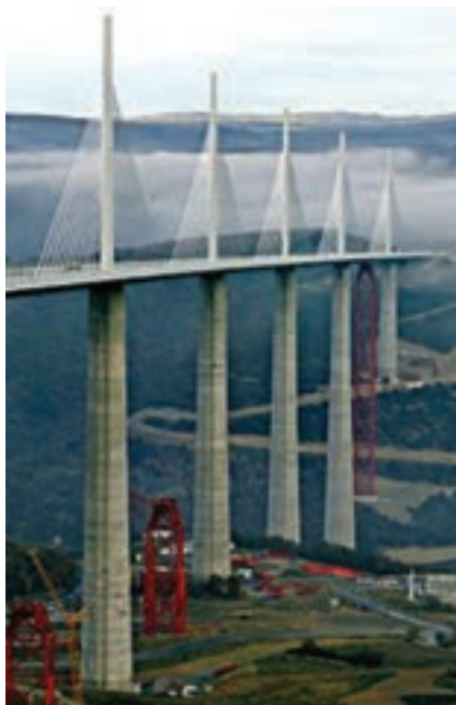
پل کابلی با پایه‌های بتنی
