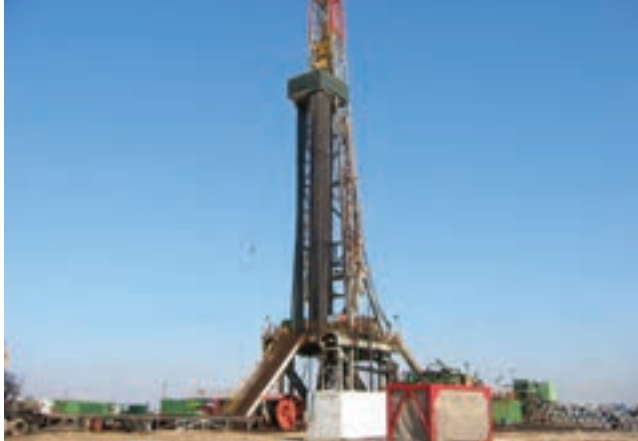
شکل ۱۰- دکل حفاری چاه‌های اکتشافی نفت و گاز
