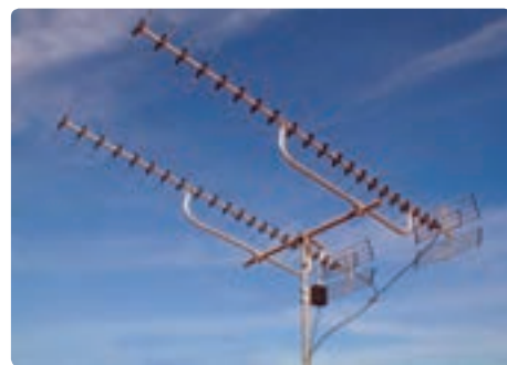
شکل ۴-۹ آنتن برپا شده و لوله آن
