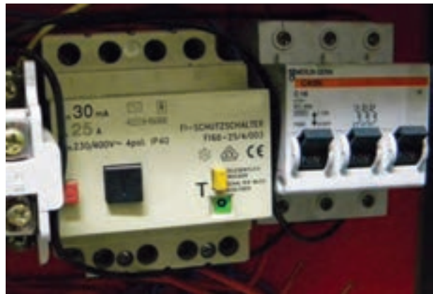
شکل ۱-۴- فیوز حفاظتی نصب شده در کارگاه
