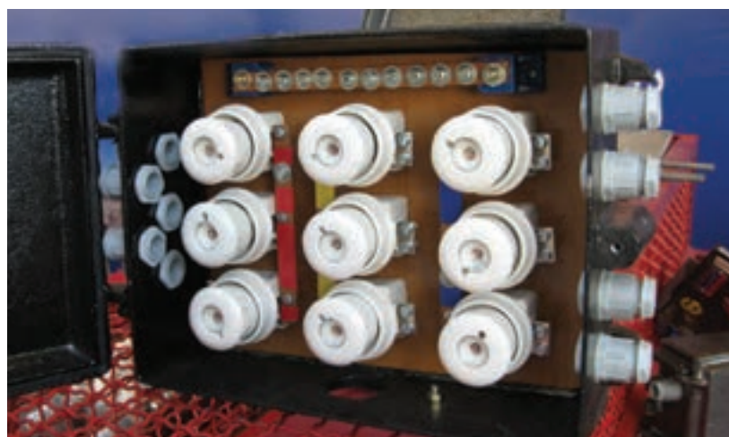
شکل ۷-۱ نمونه‌هایی از تابلوهای فیوز
