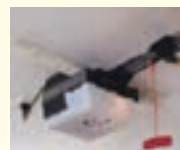
دو نمونه از سیستم‌های درب بازکن اتوماتیک درب‌های بالارونده چند تکه
