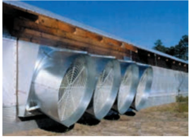
نمای هواکشها از بیرون جایگاه
