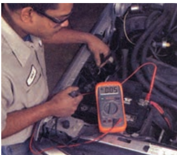
شکل ۸-۴۱- اندازه‌گیری افت ولتاژ کابل متصل به رله
