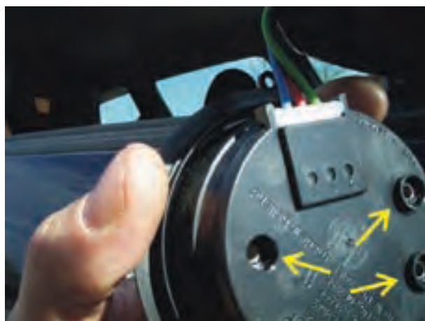
شکل ۱۷۲-۲- جدا کردن محفظه‌ی موتورهای الکتریکی
