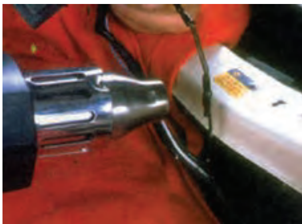
شکل ۱-۱۵۰- عایق کاری محل اتصال سیم ها
