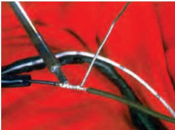
شکل ۱-۱۴۹- لحیم کاری محل اتصال سیم ها
