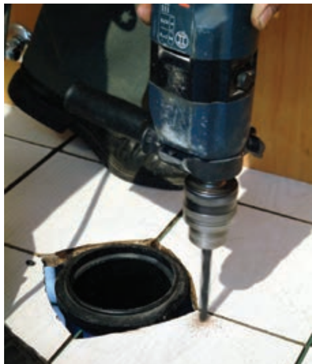
شکل ۲۴۶-۳- سوراخ‌کاری محل‌های علامت‌گذاری شده
