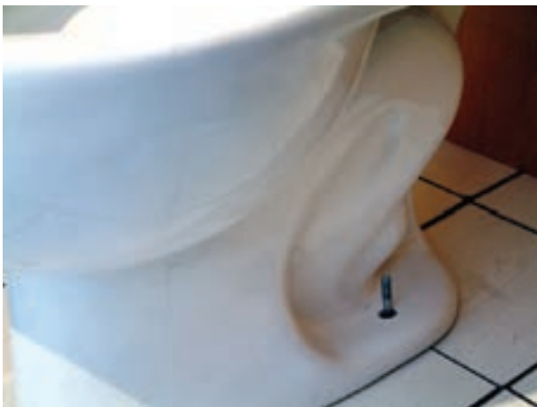
شکل ۳-۲۴۸- قرار دادن توالت فرنگی در محل خود
