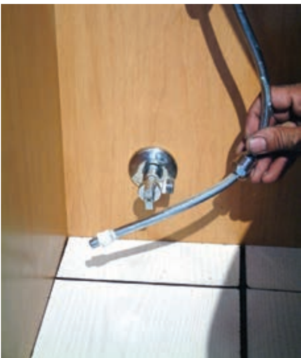
شکل ۲۵۵-۳ خمکاری لوله‌ی پیسوار
