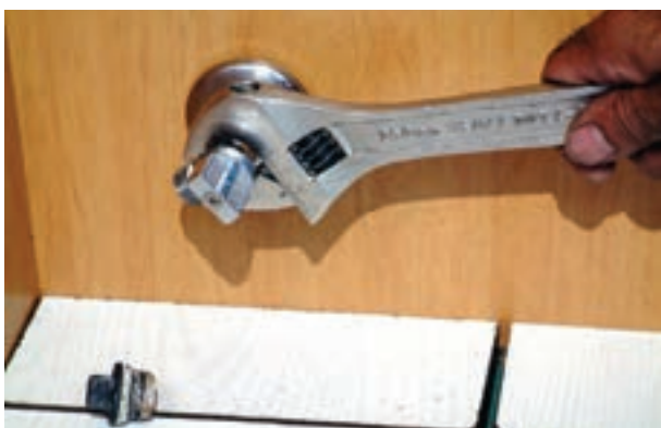
شکل ۲۵۴-۳ سفت کردن شیر پیسوار
