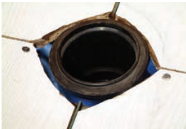
شکل ۲۴۴-۳- قراردادن بوگیر در داخل زانویی
