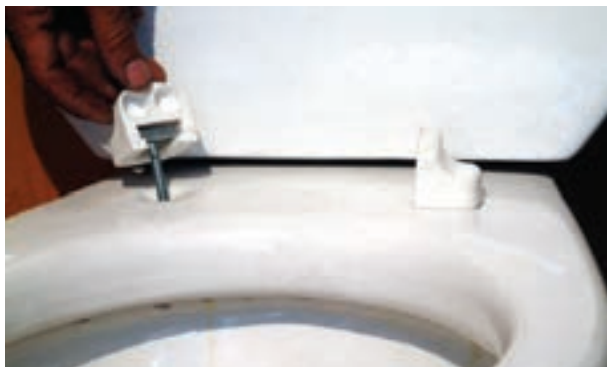
شکل ۲۵۳-۳ اتصال بست‌های نگهدارنده به توالت فرنگی
