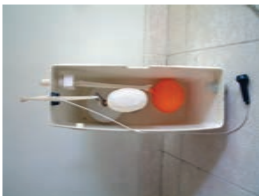
شکل ۳-۲۳۳- مخزن فشاری برش نخورده
