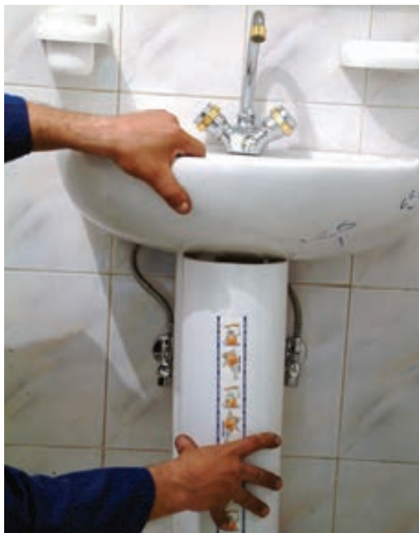
شکل ۳-۵۸- قرار دادن پایه‌ی دست‌شویی در زیر آن
