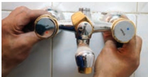
شکل ۲-۲۰۵- بستن مهره‌های شیر مخلوط دوش با دست
