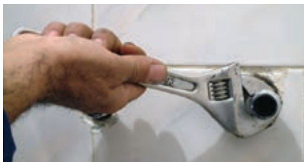
شکل ۱۶۷-۲ سفت کردن دنباله‌ها با آچارفرانسه
