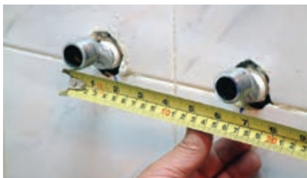
شکل ۱۶۸-۲ کنترل اندازه‌ی محور تا محور دنباله‌ها
