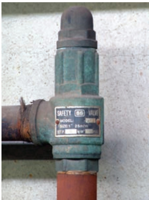
شکل ۱۰۶-۲ شیر اطمینان حساس در برابر فشار
