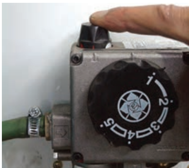
شکل ۱-۱۰۴ در حالت شمعک قرار دادن و پایین نگه داشتن دگمه‌ی فرمان
