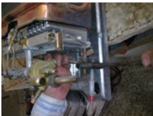
شکل ۸-۱- مبدل گرمایی
