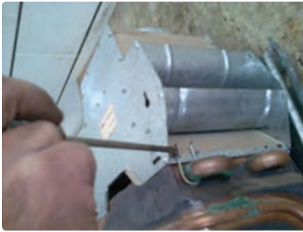
شکل ۶-۱- جدا کردن کلاهک تعدیل از مبدل
