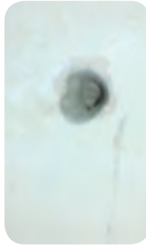
شکل ۶-۴ - محل سوراخ روی دیوار، توسط مته مشخص شده است.
