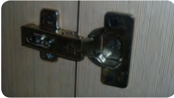
شکل ۵-۱۶۳- نصب لولای گازی فنردار به در کمد
