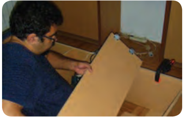
شکل ۵-۱۶۱- نصب طبقات به وسیله گونیاها فلزی
