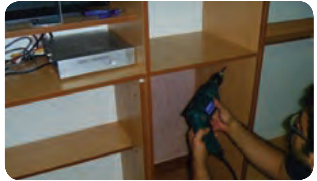
شکل ۱۷۲-۵- نصب صفحه میز آرایش
