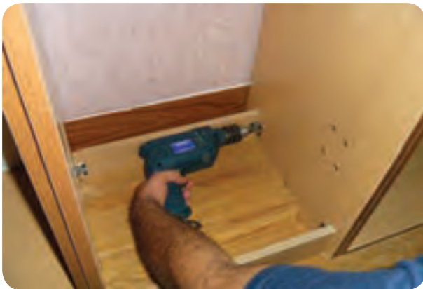
شکل ۱۸۰-۵- نصب پاسنگ‌ها
