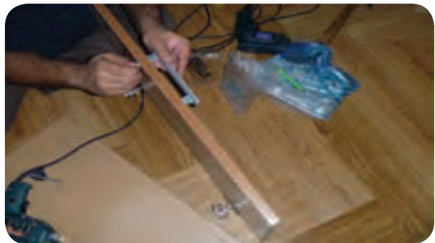
شکل ۱۵۹-۵- نصب دستگیره در کمد
