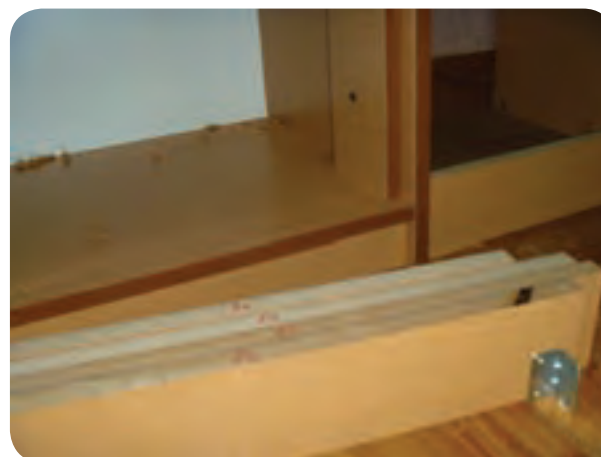
شکل ۱۶۶-۵- نصب پاننگ با استفاده از گونیای فلزی
