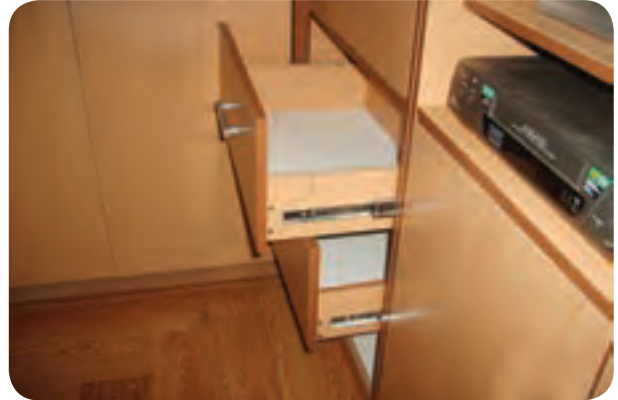
شکل ۱۷۷-۵- نصب کشویی تلسکوپی سه ريله برای کشو
