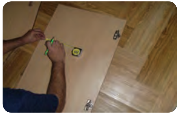
شکل ۱۵۰-۵- نصب لولای در کمد
