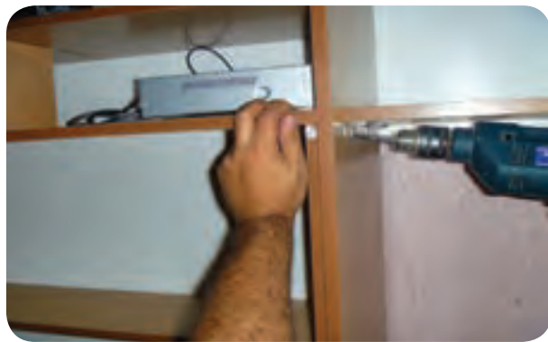
شکل ۱۴۲-۵- استفاده از اتصال گونبای فلزی در نصب طبقات
