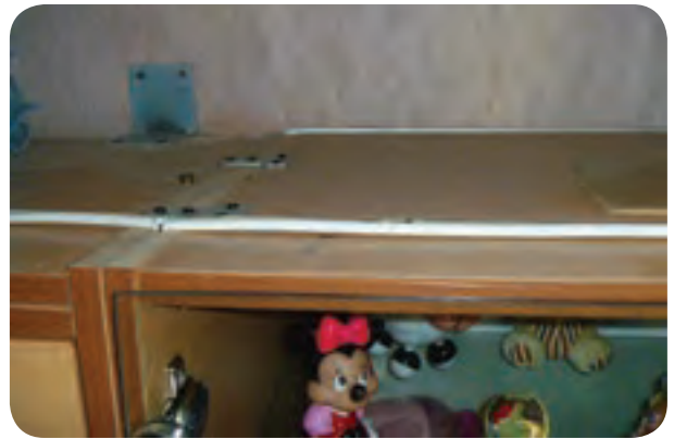
شکل ۱۸۱-۵- اتصال قسمت های مختلف دکور به یکدیگر و به دیوار
