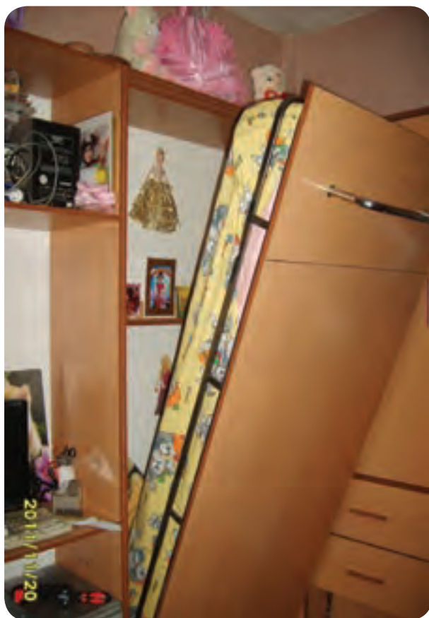
شکل ۱۸۴-۵- کنترل تعادل تختخواب به وسیله جک‌ها
