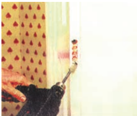
شکل ۱۰-۴۵ - تفلیه‌ی محل قفل با دریل.
