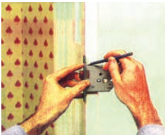
شکل ۱۰-۴۴ - فماتکشی محل قفل (روی نر کار).
