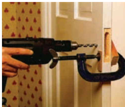
شکل ۱۰-۴۸- سوراخ‌کاری ممل پلاک و دستگیره‌ی قفل.
