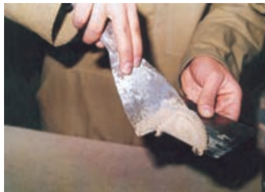
شکل ۴-۸- کاربرد لیسه و کاردک هنگام بتونه کاری.
