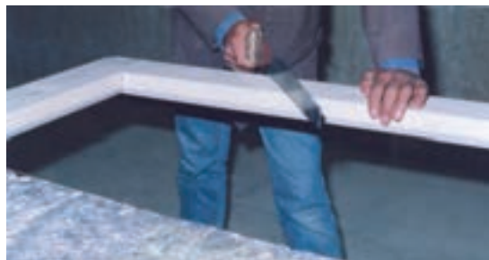
شکل ۱۱-۲۶- ایجاد شیار با اره‌ی دستی.
