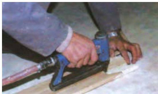
شکل ۸-۴ کاربرد منگنه در اتصال دو قطعه چوب به هم.
