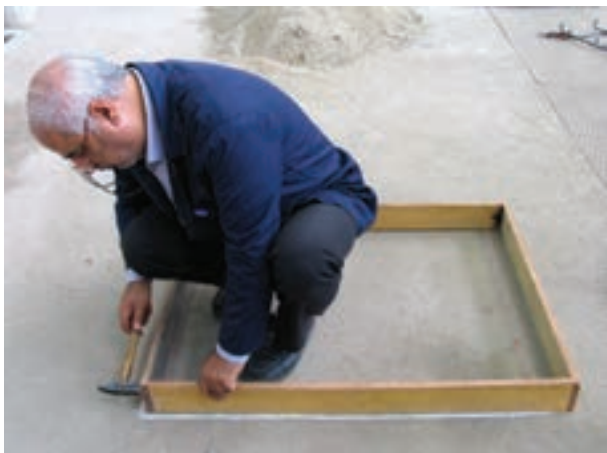
شکل ۴-۱- قالب بندی فونداسیون
