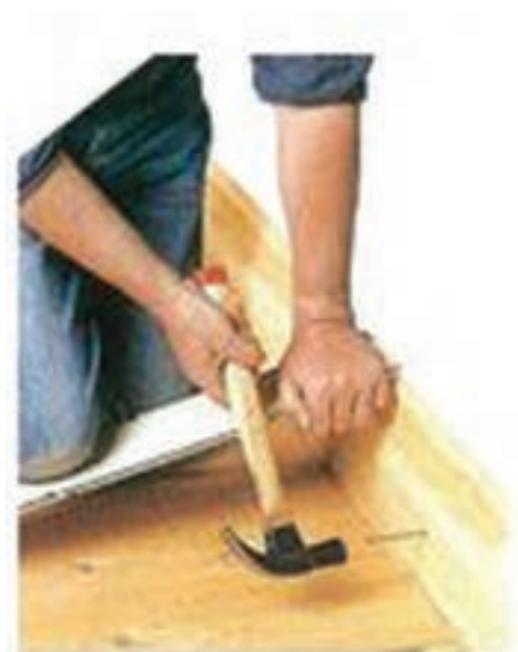
شکل ۳- ۲۹: نصب قرنیز چوبی با میخ
