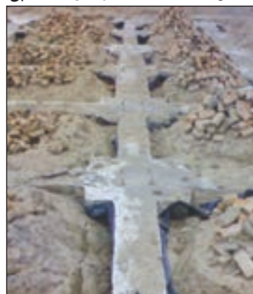
شکل ۳-۱۳۷ پی و شناژ بعد از بتن ریزی
