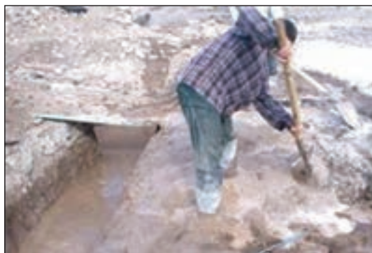
شکل ۳-۳۷ اجرای شفته آهک در فونداسیون
