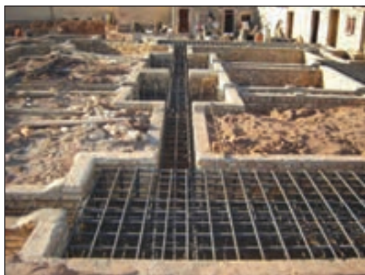
شکل ۳-۱۳۴ میلگردگذاری در پی کلاف بندی
