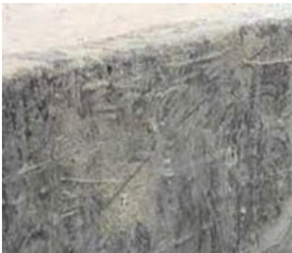
شکل ۱ - ۱۱ : عایق کاری دیوار محافظ
