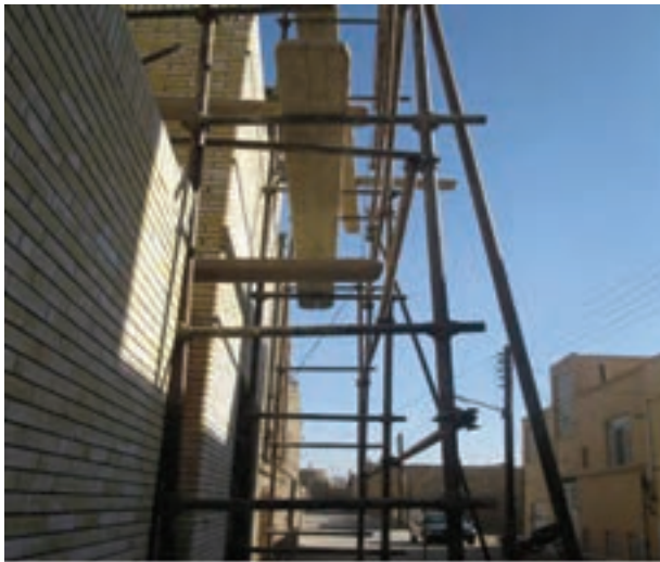
شکل ۱-۱: داربست فلزی برای چیدن دیوار
