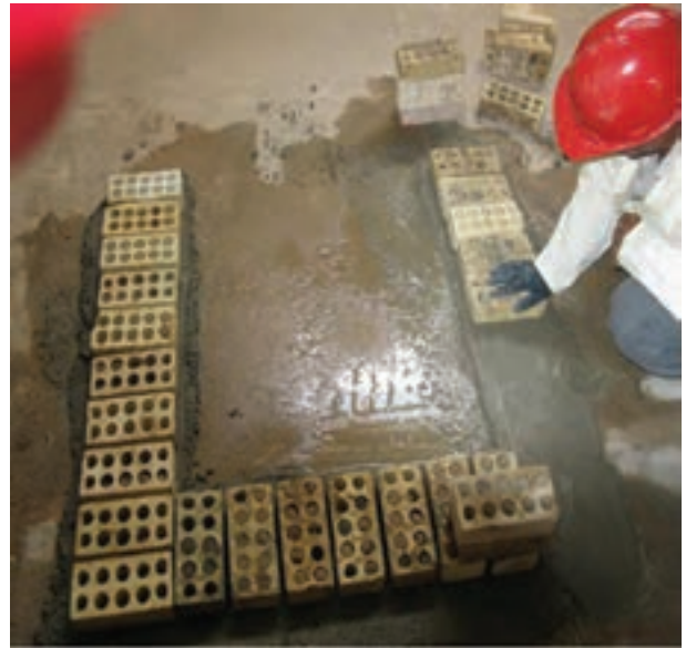
شکل ۱ - ۳۳ (ج): ریسمان کشی و چیدن ضلع سوم
