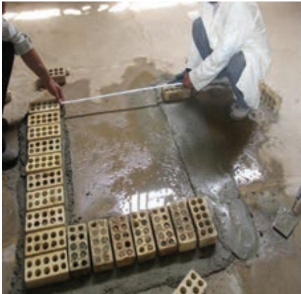
شکل ۱ - ۳۳ (ب): جدا کردن اندازه دو طرف دیگر
