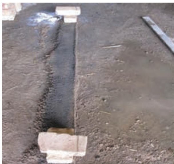
شکل ۱- ۹۰: بادخور نمودن ریسمان کار
