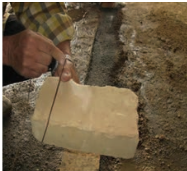
شکل ۱- ۷۲: نحوه بستن ریسمان کار به آجر
