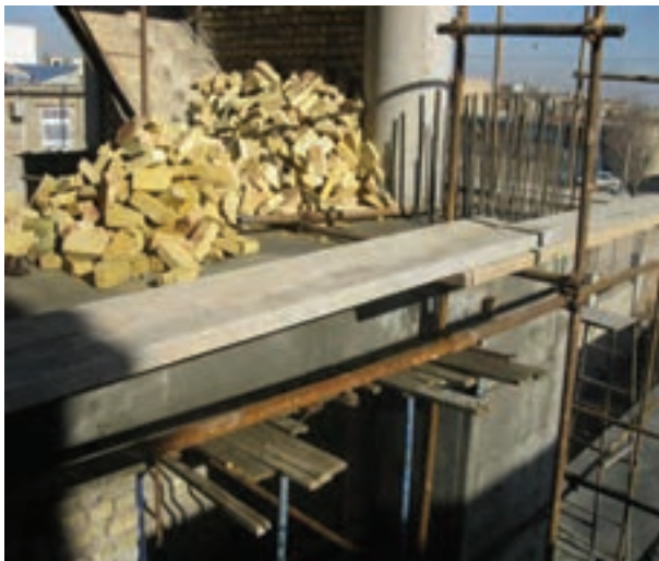
شکل ۱-۲: ضخامت مناسب برای تخته زیر پای
