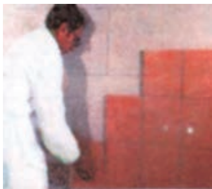
شکل ۱ - ۴۳: نصب کاشی روی قطعات پیش ساخته گچی
