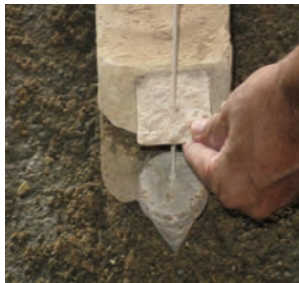
شکل ۱-۹۴: شاقول کردن نبش کار
