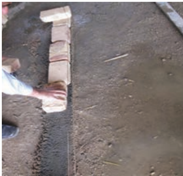
شکل ۱-۹۱: نحوه چین آجر در امتداد ریسمان کار
