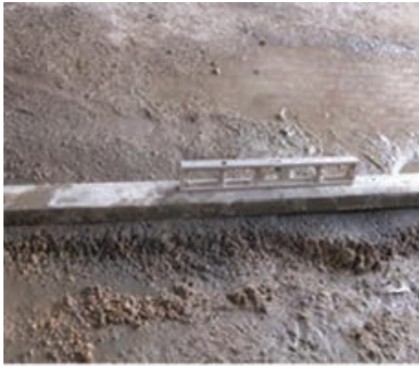
شکل ۱- ۶۹: تراز کردن روی ملات
