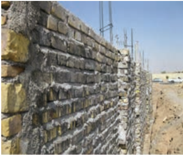
شکل ۱- ۲۶: دیوار آجری با کلاف بندی قائم
