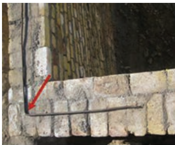
شکل ۱ - ۵۵: میلگرد گذاری در محل اتصال دو دیوار
