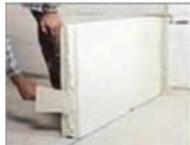
شکل ۱ - ۳۶: طریقه نصب بلوک های گچی
