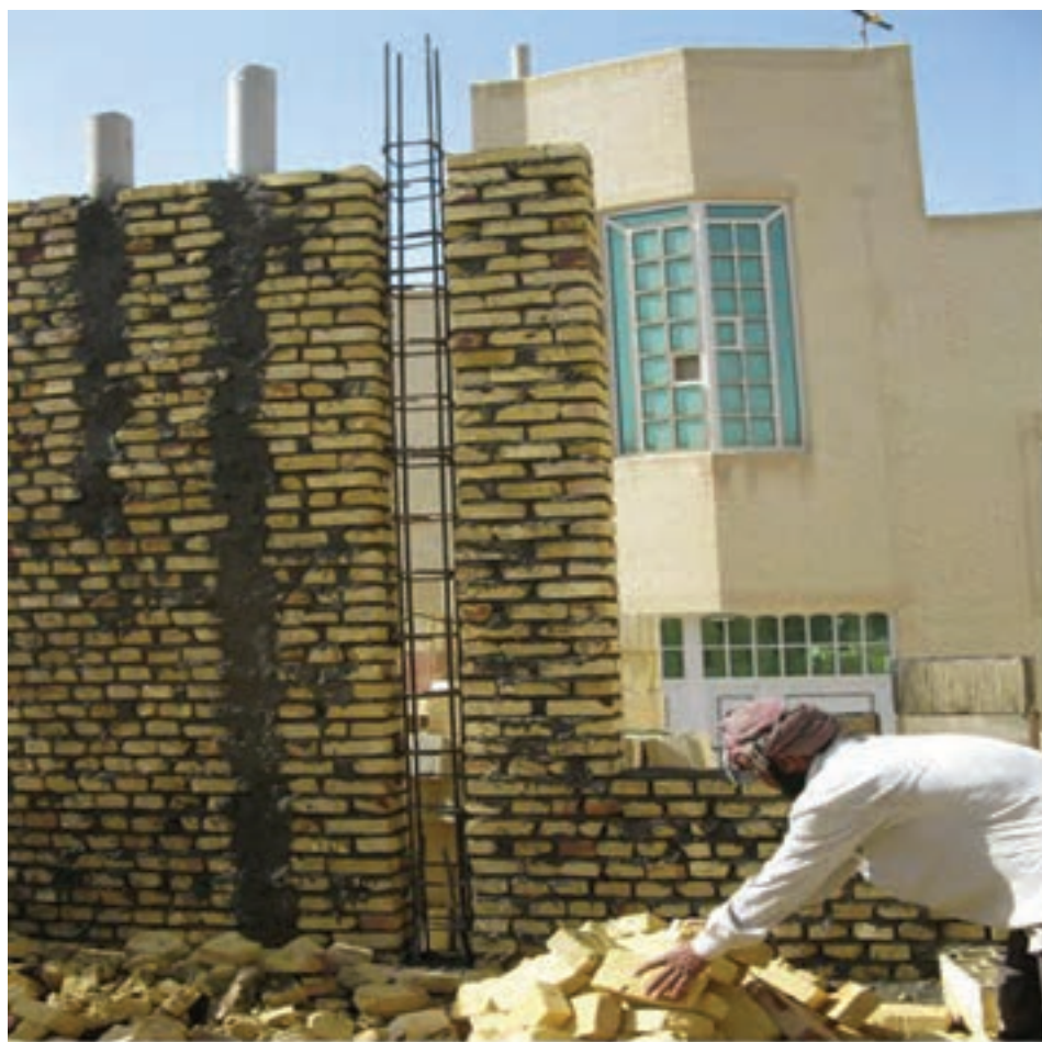
شکل ۱ - ۶۰: اتصال کلاف قائم و افقی در دیوار
