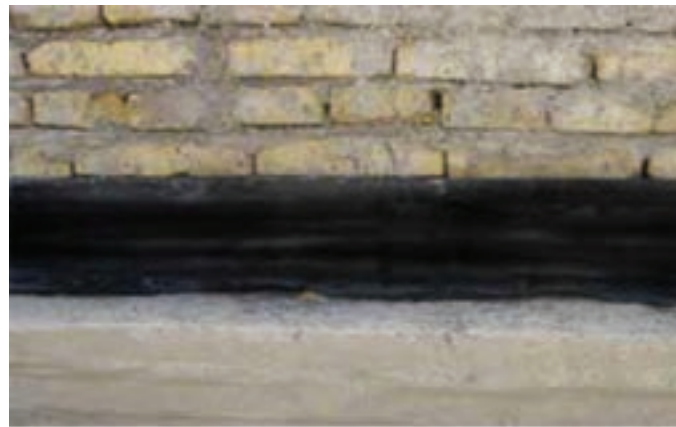
شکل ۱- ۳۰: دیوار روی کرسی چینی
