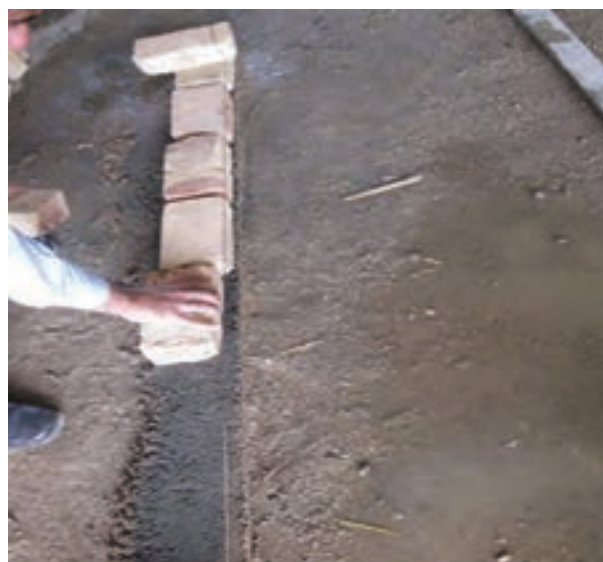
شکل ۱- ۷۴: نحوه چیدن آجر در امتداد ریسمان کار
