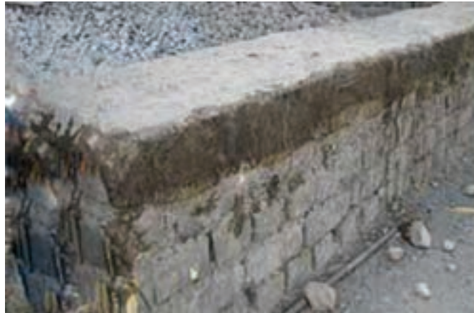
شکل ۱- ۲۹: کرسی چینی یا عایق کاری رطوبتی
