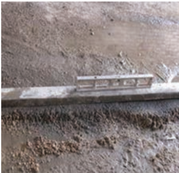
شکل ۱ - ۸۶: کنترل تراز سطح ملات
