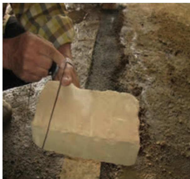
شکل ۱- ۸۹: نحوه بستن ریسمان کار به آجر
