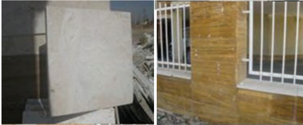
شکل ۱-۱۸: کاربرد سنگ رسوبی در نما
