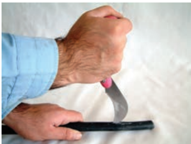
الف - نحوه‌ی غلط لخت کردن کابل
