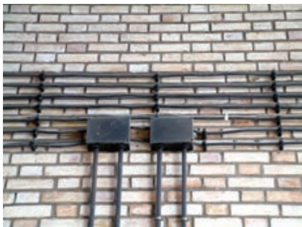
شکل ۵-۵۷- کابل‌کشی روی دیوار
