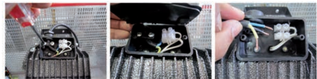
شکل ۲-۲۵ - سیم کشی در جعبه اتصالات
