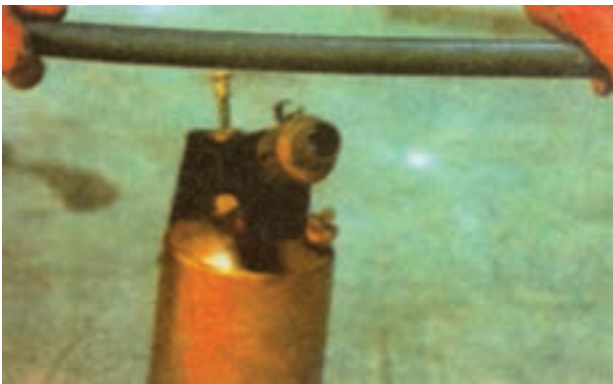
شکل ۴-۴۳- حرارت دادن لوله ی PVC
