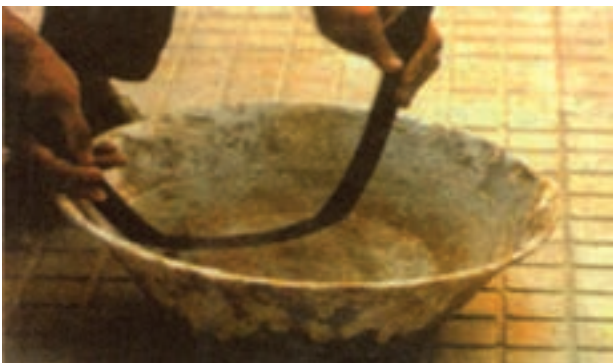
شکل ۴-۴۵- سرد کردن لوله پس از خم کاری
