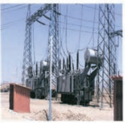
شکل (۲۸-۳) دوترانسفورماتور موازی شده
