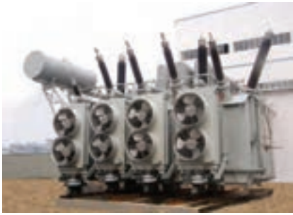
شکل (۳-۱) ترانسفورماتور خطوط انتقال
