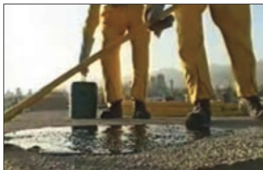
شکل ۲۲-۶ قیرگونی پس از پرکردن بین کُرْم‌ها
