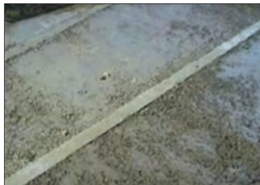
شکل ۲۱-۶ پرکردن فضای بین کرم‌ها با پوکه معدنی
