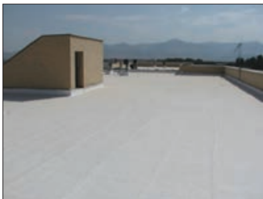
شکل ۱۲-۶ سطح پشت بام
