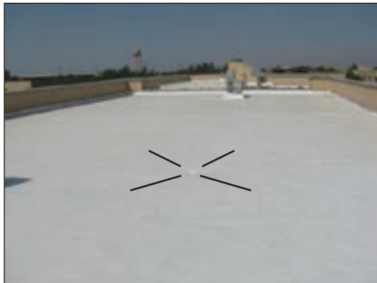
شکل ۱۱-۶ سطح پشت بام
