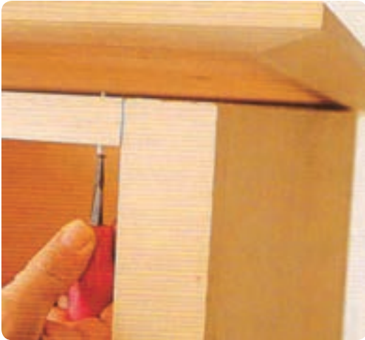
شکل ۶۹-۸ بستن صفحه روی کابینت
