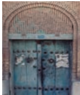
▲ شکل ۴-۷ کاربرد قوس در نعل درگاه
