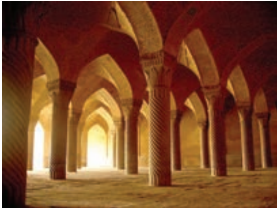
▲ شکل ۴-۶۹ قوس‌های آجری (مسجد وکیل شیراز)
