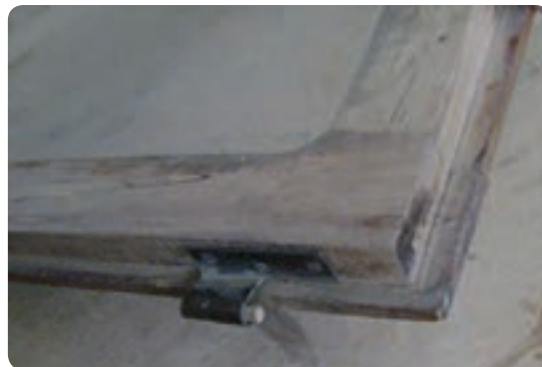
شکل ۶-۹۱ نصب لولای قابل‌ه‌ای در دو راهه در
