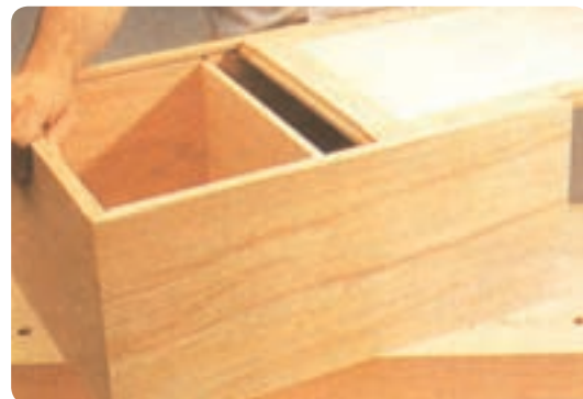
شکل ۱۴۳-۶ قرارگیری پشت بند در کنشکاف بدنه کابینت
