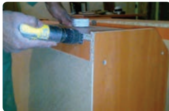
شکل ۱۳۱-۶ نصب لولای محفظه جاواکسی
