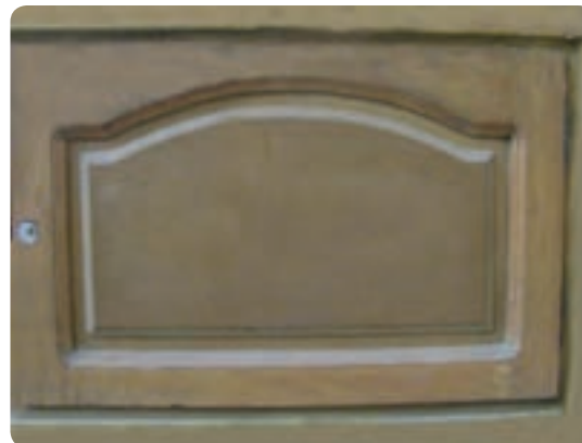
شکل ۶-۸۷ در قاب و تنکه‌ای کابینت
