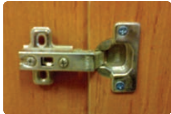
شکل ۸۵-۶ نصب کاسه لولا روی در کابینت
