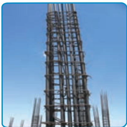
شکل ۱۹-۷- کار گذاشتن میلگردهای انتظار ستون، در فونداسیون
