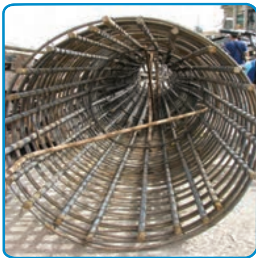
شکل ۲۰-۷- میلگرد گذاری مارپیچ در ستون
