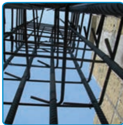
شکل ۱۹-۷- کار گذاشتن میلگردهای انتظار ستون، در فونداسیون
