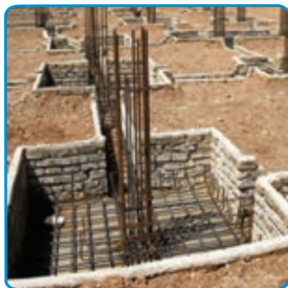
شکل ۴-۷- اجرای میلگردهای ریشه انتظار
