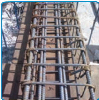
شکل ۷-۲۵- بستن خاموت ها با مفتول
