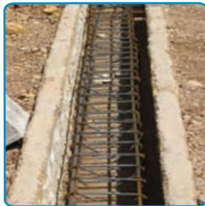
شکل ۵-۷- اجرای میلگرد شناژها
