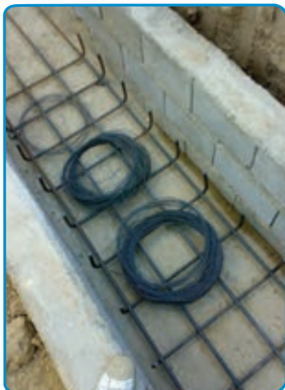
شکل ۷-۹- بهم بستن میلگردها
