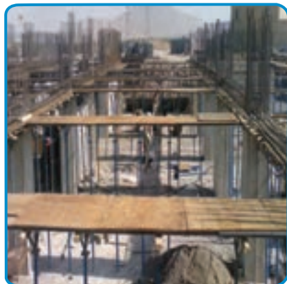
شکل ۷-۲۱- قالب بندی تیرها
