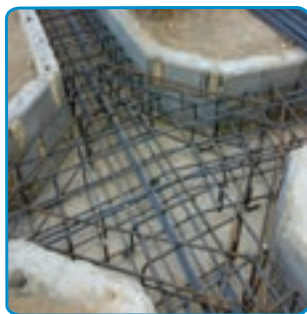
شکل ۱۴-۷- تکمیل میلگردگذاری محل اتصال ستون
