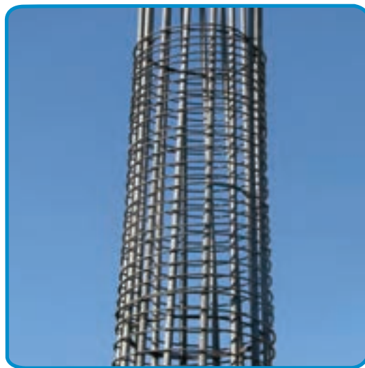
شکل ۲۰-۷- میلگرد گذاری مارپیچ در ستون
