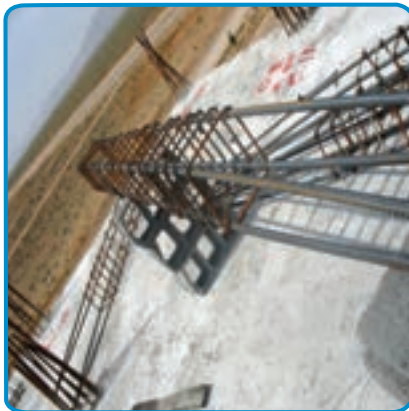
شکل ۷-۲۲- آماده کردن میلگردهای تیر روی زمین
