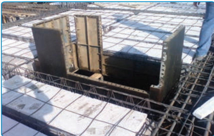
شکل ۳۵-۷- تکمیل قالب بندی
