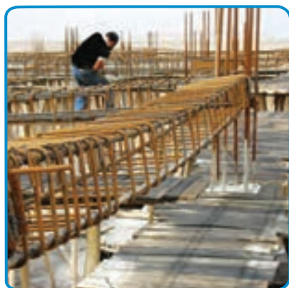
شکل ۷-۲۴- تنظیم فاصله بین خاموت ها
