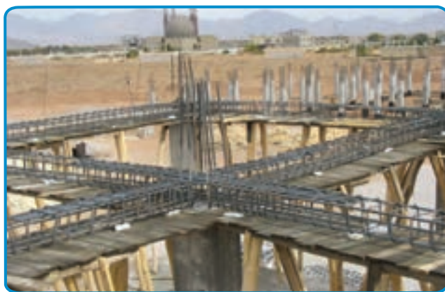
شکل ۷-۲۷- رعایت فاصله پوشش بتنی در کف
