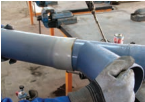
شکل ۲-۱۰- خارج کردن فیتینگ از سرکاسه
