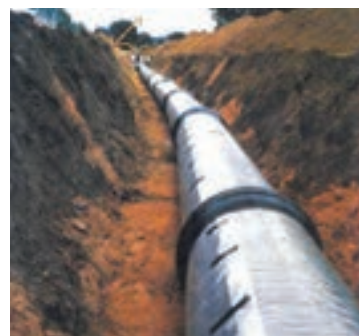
▲ شکل ۲-۲۱ لوله کشی انتقال آب شهری
