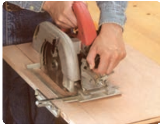
شکل ۲-۲۲ برش عرضی با گونیای ماشین
