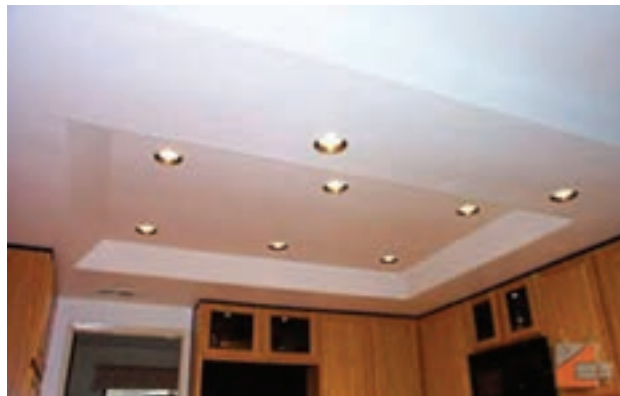
▲ شکل ۱-۵۸- سقف کاذب از نوع رابیتس با اندود گچی و رابیتس کاری زیر سقف کاذب
