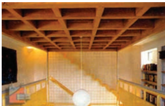
◀ شکل ۱-۵۹- سقف کاذب مشبک چوبی
