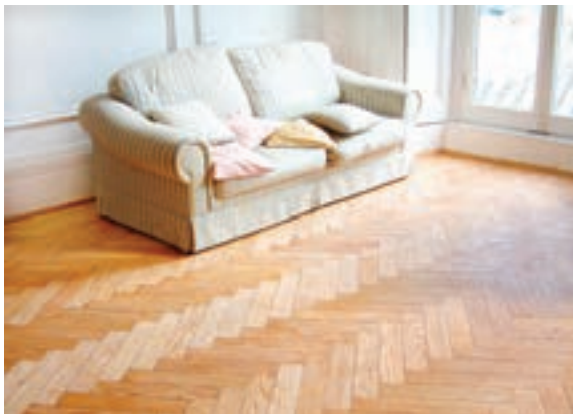
▲ شکل ۱-۶ استفاده از پارکت‌های چوبی در نشیمن
