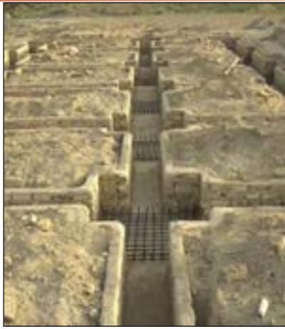
شکل ۴۸-۱ آرماتورگذاری پی تکی کلاف بندی شده
