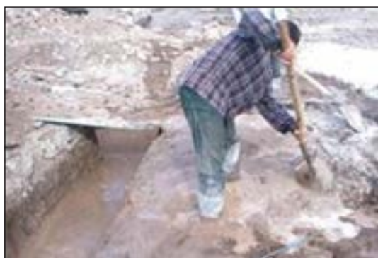
شکل ۱-۳۱ اجرای شفته آهک در فونداسیون
