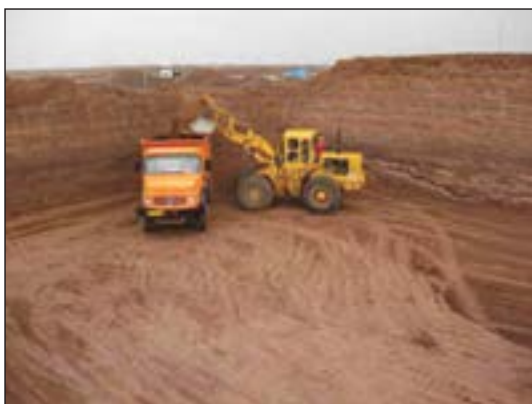
شکل ۸۵-۱ گودبرداری با لودر در زمین نامحدود
