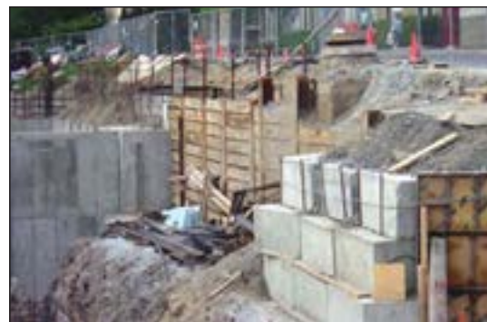
شکل ۹۱-۱ مهاربندی با دیوار مانع چوبی
