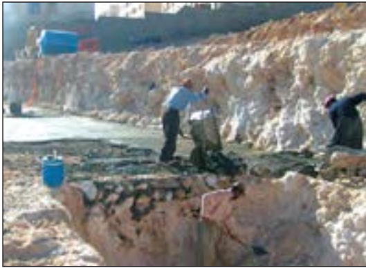
شکل ۸۷-۱ گودبرداری دستی (با بیل و کلنگ)
