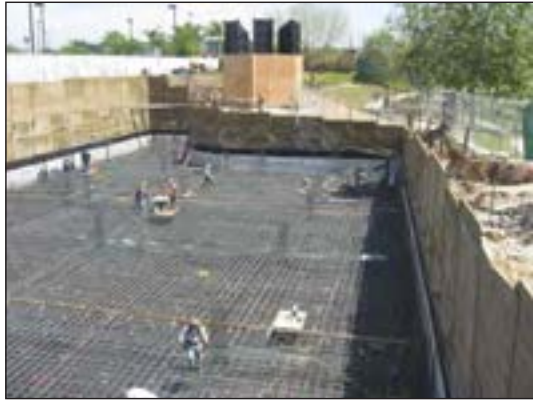
شکل ۱-۶۲ پی بتن مسلح یکپارچه (رادیه ژنرال)
