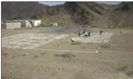
شکل ۸۳-۱ پیاده کردن نقشه روی زمین
