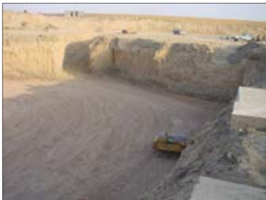
شکل ۸۴-۱ زمین گودبرداری شده
