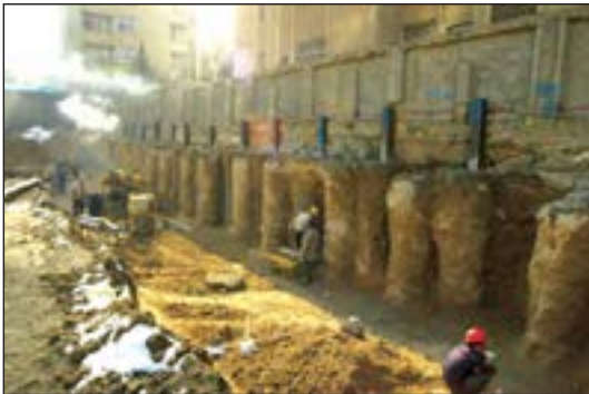
شکل ۸۸-۱ مهاربندی با پشت بند خاکی ستونی
