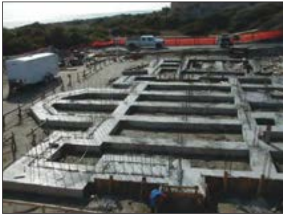
شکل ۱-۵۶ پی بتن مسلح نواری شبکه ای زیرستون
