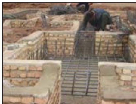
شکل ۱-۸۲ قالب‌بندی آجری در اطراف پی
