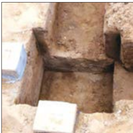
شکل ۱-۸۱ پی‌کنی از نوع پی‌کلاف‌بندی شده (پی‌منفرد و شناژ) جداره‌های اطراف پی نقش قالب را ایفاء می‌کنند.
