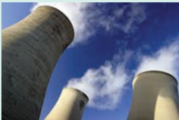
شکل ۷-۱۴- برج‌های اتمسفریک خنک کننده
