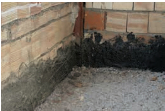
تصویر ۱۶ - عایق کاری کف سرویس بهداشتی
