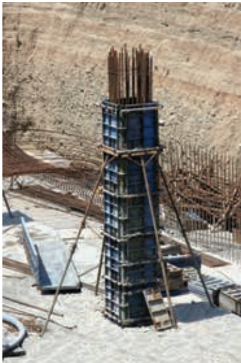
تصویر ۴ - قالب‌بندی فلزی ستون
