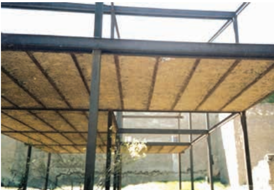
تصویر ۱۰ - تیرریزی سقف طاق ضربی
