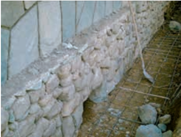
تصویر ۱- پی و دیوار سنگی
