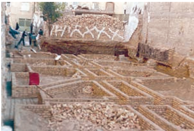
تصویر ۵ - قالب بندی آجری بی ساختمان
