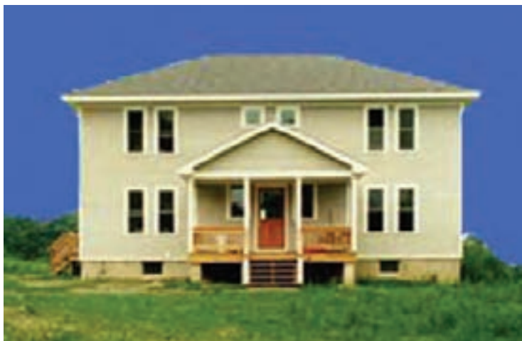
شکل ۱۶-۱- نمای ساختمان اجرا شده
