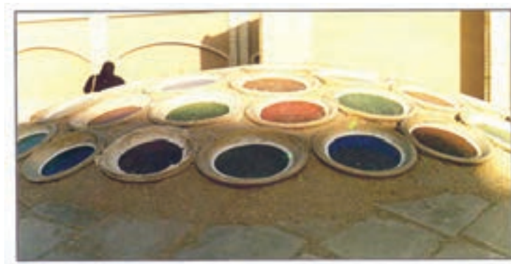
شکل ۲-۱۲- استفاده از گلجام در بازسازی سقف حمام
