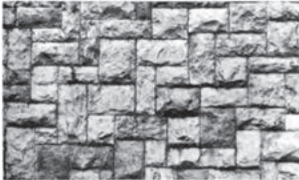
شکل ۹-۴- استفاده از سنگ بادر در نما
