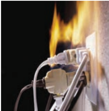
شکل ۱-۲- آتش سوزی حاصل از عبور جریان زیاد از سیم و ذوب شدن سیم های برق
