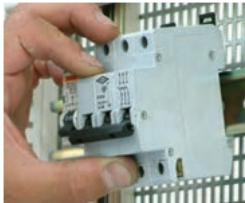
شکل ۸-۲- طرز قرارگیری فیوز مینیاتوری روی ریل
