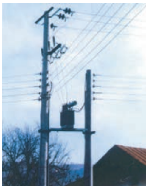
شکل ۸-۱ - تبدیل ولتاژ ۲۰ کیلو ولت به ۴۰۰ و ۲۳۰ ولت
